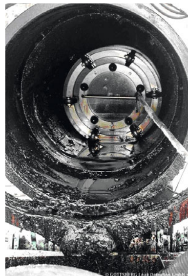
Bild 5. Entnahme aus der Molchschleuse.
